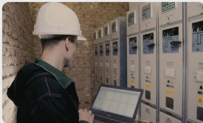
Наладка всего КРУ с использованием единственного ПО TELARM Lite
